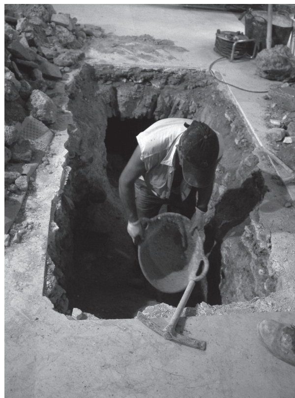
Excavando en el subsuelo.
