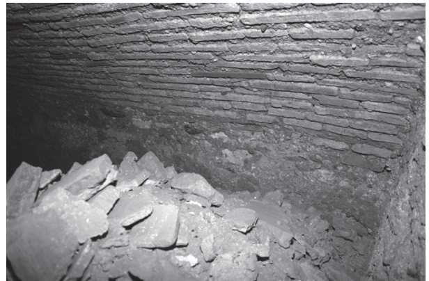
Bóveda de ladrillo de una de las criptas bajo la Capilla Marraja.
