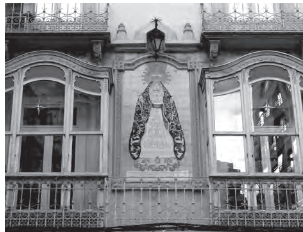
Fachada Edificio Plaza San Sebastián.
